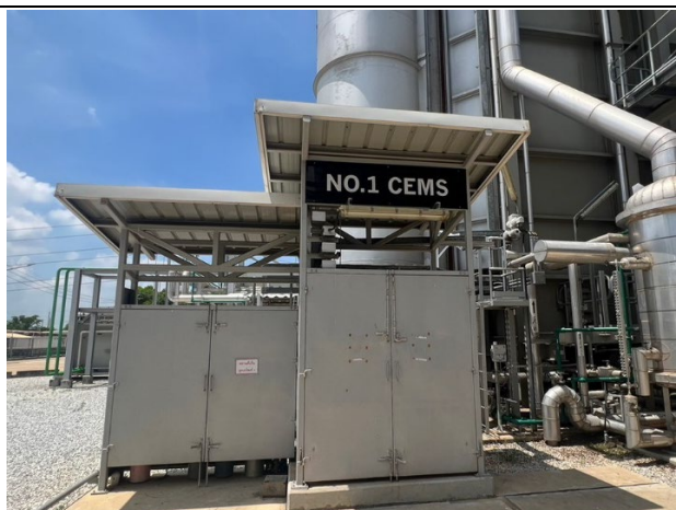
รูปที่ 2-3.1 ระบบตรวจวัดคุณภาพอากาศแบบต่อเนื่อง (CEMs) ของ HRSG 1
