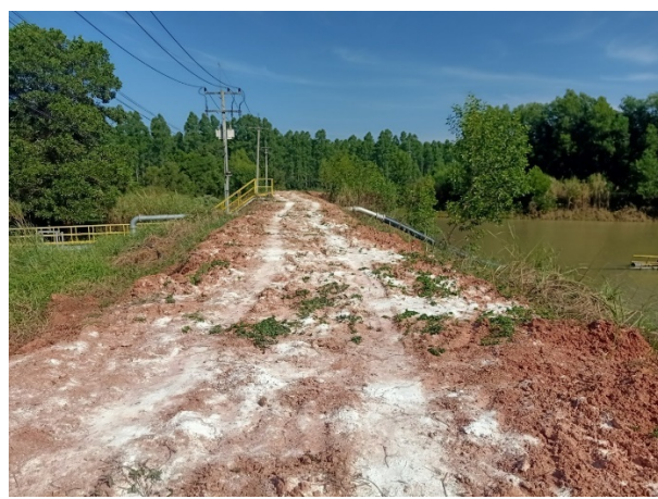
รูปที่ 2-2.1 (4) การปรับปรุงคุณภาพดินของโครงการ
