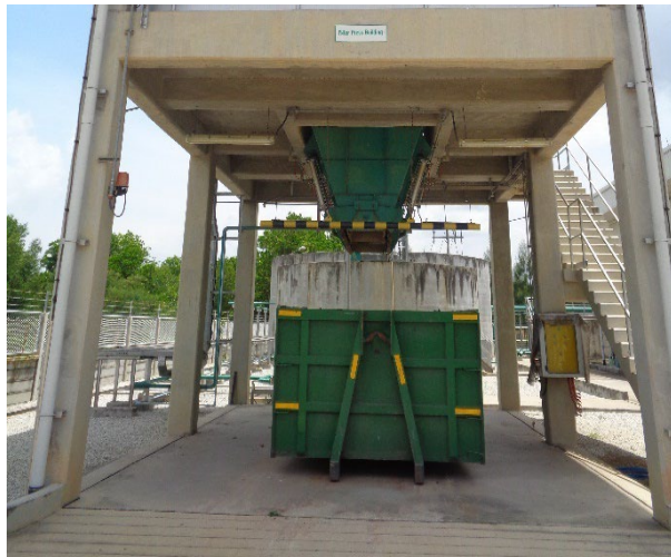
รูปที่ 2-10.2 ภาพขณะบรรจุกากตะกอนจากระบบปรับปรุง คุณภาพน้ำ
