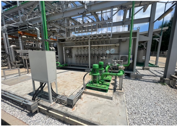
รูปที่ 2-15.8 ท่อตรวจวัดคุณภาพน้ำและไอน้ำ
