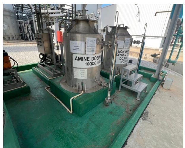
รูปที่ 2-14.14 Berm สำหรับป้องกันสารเคมีรั่วไหล
