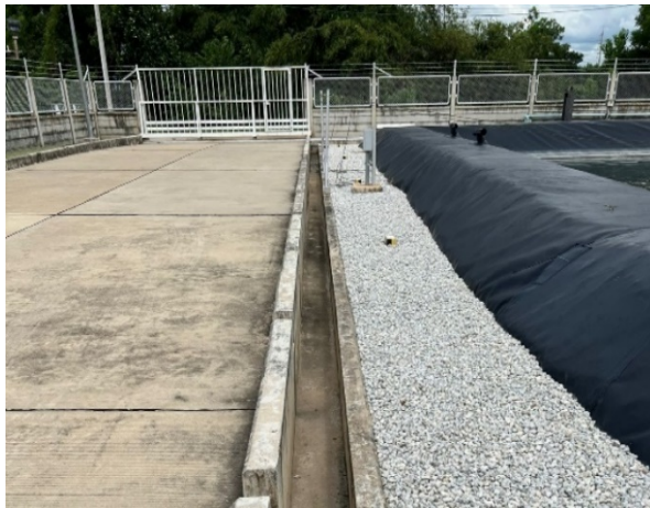
รูปที่ 2-11.2 รางระบายน้ำฝนที่ปนเปื้อน
