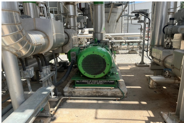
รูปที่ 2-15.4 ปัมเติม HRSG สำรอง
