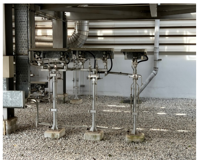
รูปที่ 2-15.7 อุปกรณ์ตรวจวัดแรงดันไอน้ำ
