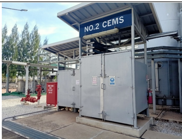
รูปที่ 2-3.2 ระบบตรวจวัดคุณภาพอากาศแบบต่อเนื่อง (CEMs) ของ HRSG 2
