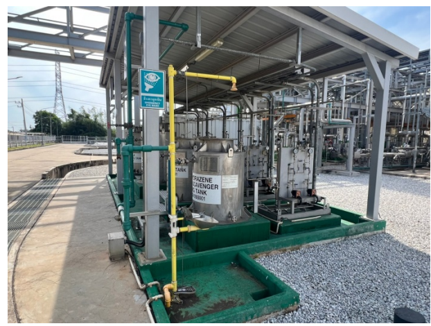
รูปที่ 2-14.6 อุปกรณ์ชำระล้างฉุกเฉิน
