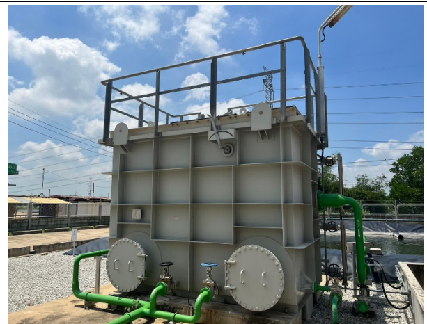
รูปที่ 2-5.4 ระบบ Oil Separator
