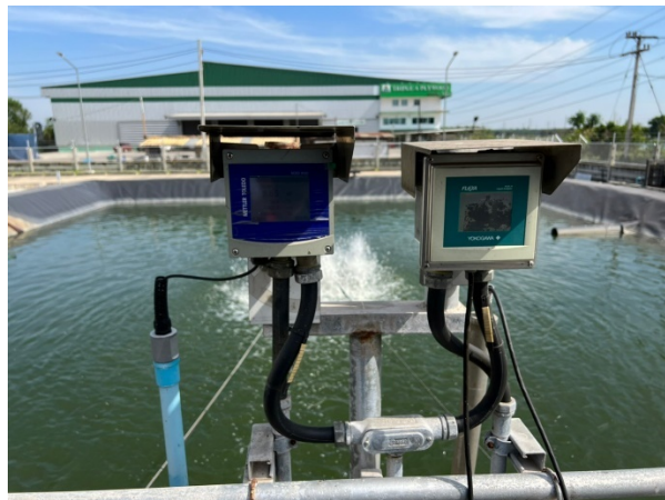
รูปที่ 2-5.2 (1) อุปกรณ์ตรวจวัดน้ำแบบ Online monitoring
